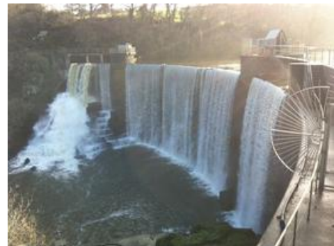
La retenue de Pont Rolland (crédit : Préfecture des Côtes d'Armor)
