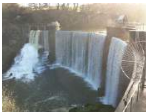
La retenue de Pont Rolland (crédit : Préfecture des Côtes-d'Armor)
